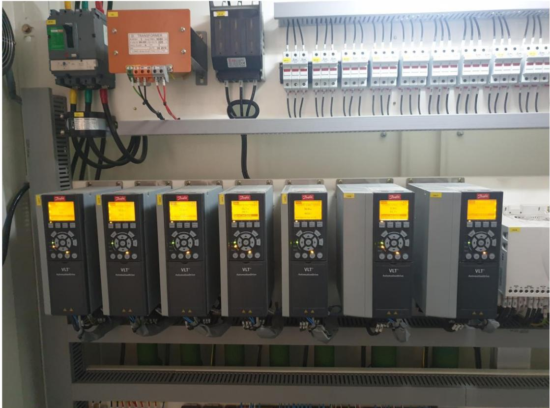
使用 DANFOSS 伺服驅動器控制搭配高解析
